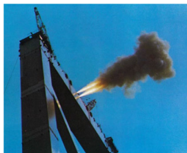
ロケットによる主塔の振動実験 (昭和46年5月13日)
