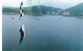
パイロットロープ渡海(門司側から下関へ) (昭和46年6月16日)
