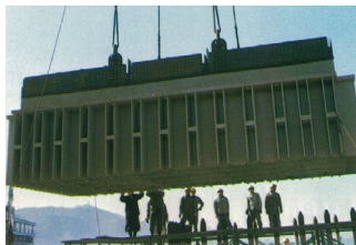
門司側主塔第1段架設 (昭和45年10月)
