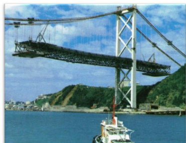
補剛桁架設（下関側） （昭和 47 年 8 月 22 日）
