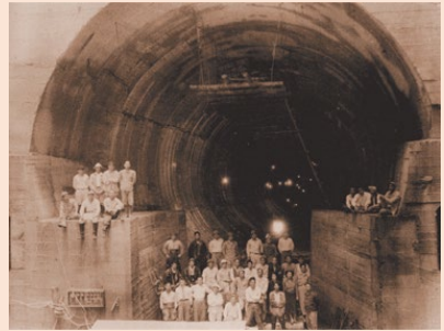
海底部の一次覆工が完成した下関側のトンネル内部と工事従事者（昭和27年6月） （「プロジェクト九州第1巻」より）
