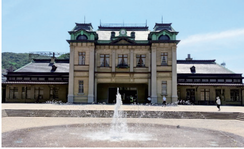
新駅舎と駅前広場 (国指定重要文化財、近代化産業遺産)
