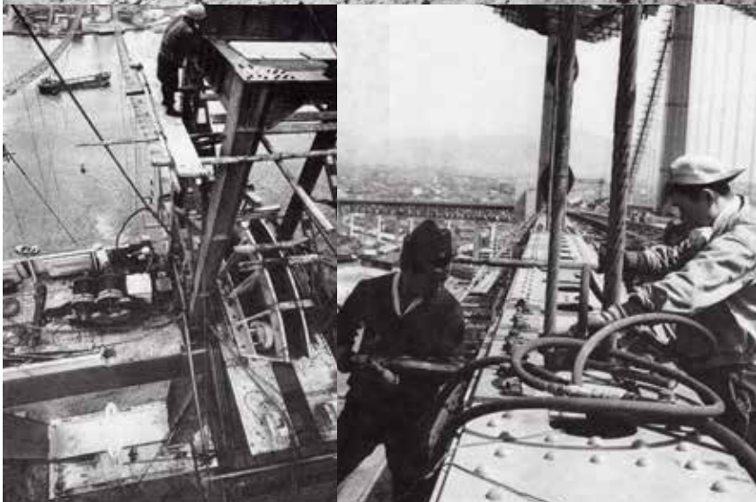
上／中間橋脚ケーソンで高圧と湧水に悩まされながらの海中作業 右下／エア・ハンマーによる作業 左下／海上100メートルでのガイドロープ取り付け 写真提供／毎日新聞社 毎日グラフ臨時増刊号 1962・5/5 若戸大橋完成記念号
