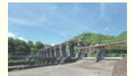
① 夜明ダム 昭和29年(1954)に完成した発電ダム。建設中に起きた28水害で一部が破損。ダム完成により上流の袋野堰が水没した。
