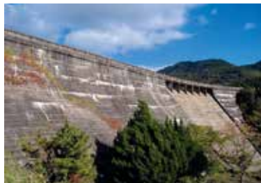
本河内低部 (水道) 堰堤
