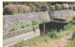
⑦ 長野サイフォン・長野水神社 昭和33年(1958)、隈上川に合流していた大石水道を、川底を潜ってサイフォンによって流れ出る仕組みに改造した。
