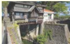
⑪ 堀川用水 過去の取水口は下流側だったが土砂が溜まり取水できなくなったため、享保7年(1722)に岩を切り貫いて取水口が作られた。
