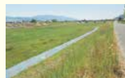
⑥ 筑後川大石分水路 昭和28年(1953)の大水害を受けて計画された。洪水時に安全に水を流すための分水路で、昭和43年(1968)に完成。
