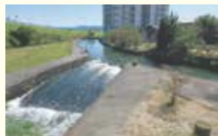
⑧ 角間天秤 大石水道の水を水量調節し分配するための施設。水路内に置かれた大石により水量を調節している。
