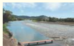
⑩ 山田堰・水神社 堀川用水の水量を増やすために築造された堰。昭和55年(1980)の水害で損傷し、現在の堰はその翌年に復旧されたもの。
