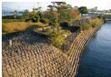
鹿児島港 (旧) 第一防波堤
