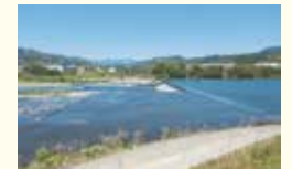
④ 大石堰 五庄屋が水利に恵まれない吉井町以西のために計画し、久留米藩の藩営事業として実施。大石水道の取水量を上げるため設置された。
