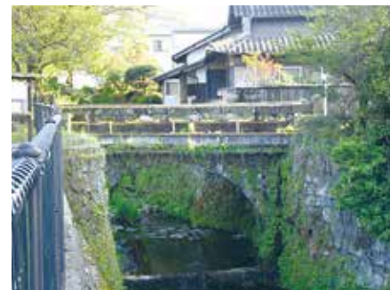
11 天神橋(めがね橋) 肥後・種山石工の名棟梁・卯助が手掛けたアーチ型の石橋は、ゆがみもなく現役で活躍中です。
