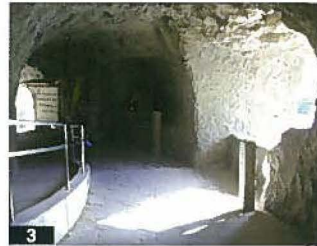
青の洞門 あおのどうもん ■所在地：中津市本耶馬溪町曾木 ■完成年：初代人道1763年(宝暦13年) 明治40年再掘削 ■県指定史跡 ●延長：223m ●幅：5.7m ●素掘トンネル 1 競秀峰の勇壮な景観は多くの観光客を魅了する 2 舊の洞門を拡張する形でつくられた明治の国道トンネル 3 江戸期に掘られた旧道部分には明かり採りの窓が残る
