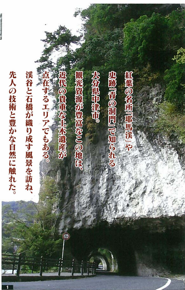
青の洞門 あおのどうもん ■所在地：中津市本耶馬溪町曾木 ■完成年：初代人道1763年(宝暦13年) 明治40年再掘削 ■県指定史跡 ●延長：223m ●幅：5.7m ●素掘トンネル 1 競秀峰の勇壮な景観は多くの観光客を魅了する 2 舊の洞門を拡張する形でつくられた明治の国道トンネル 3 江戸期に掘られた旧道部分には明かり採りの窓が残る
