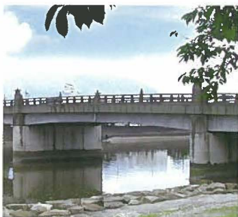
2 天保山橋と天保山橋の石灯籠型親柱
