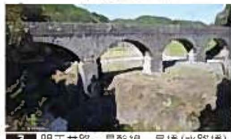
3 明正井路一号幹線一号橋(水路橋) めいせいしらいちごうかんせいのきり
