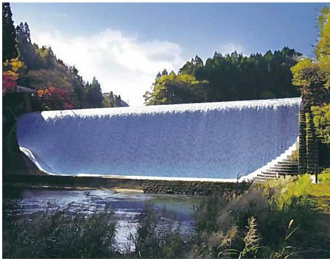
4 白水(溜池)堰堤 はくすい(ためいけ)えんてい
