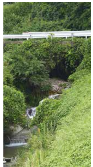
2 古殿橋 ふるとのはし
