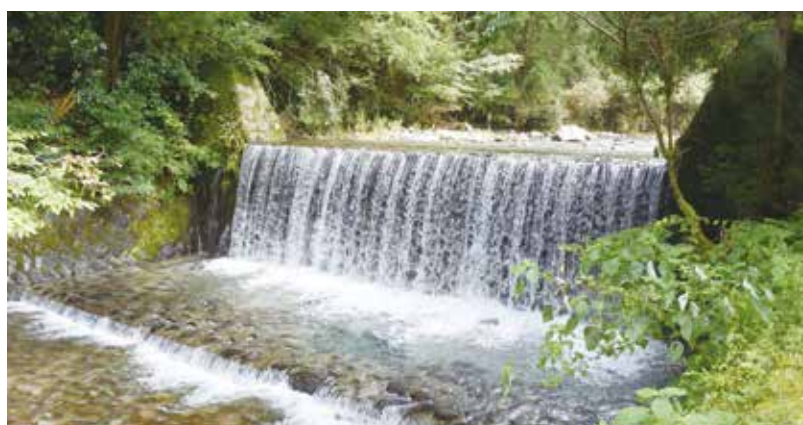
9 白弘砂防堰堤 うすのはらいさほうえんてい
