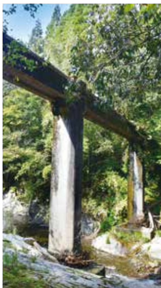
2 牧野地区用水の水路橋 まきのちくようすい の すい の すい の き の う
