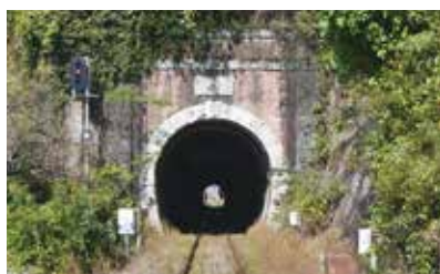
南風崎トンネル はえのさきとんねる
