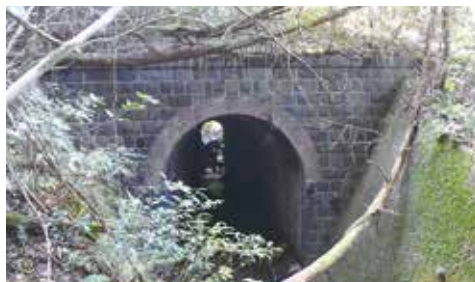
3 瀬久谷川暗渠 (せくとにかわあんぎよ)
