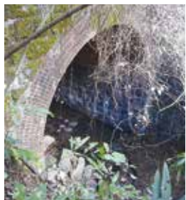
2 山下須屋川暗渠 (やましたすやかわあんぎよ)
