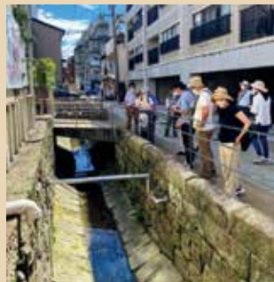
地下水への汚水の浸透を防ぐための板石と石積み護岸
