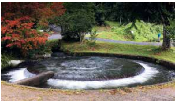
円形分水 ○熊本県上益城郡山都町
