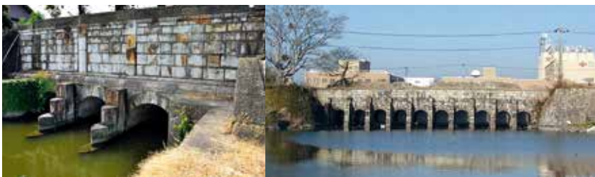
郡築二番町樋門
