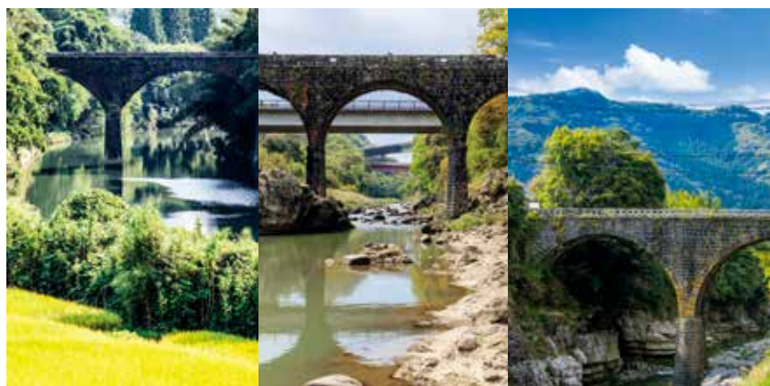
両岸が激しく侵食された恵良川にしっかりと立つ御沓橋（みくつばし）。大正14年（1925）完成
