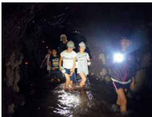
上／3年に1度の袋野隧道見学会 右／岩盤の硬さに、筑後川がS字型に湾曲している。 大石、山春地区には、袋野水道によって約390ヘクタ ルの水田が広がる 『筑後川繪圖』 筑後川歴史散策（筑後川河川事務所）より引用
