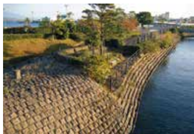
鹿児島港 (旧) 第一防波堤
