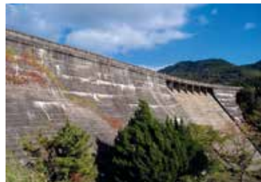
本河内低部 (水道) 堰堤
