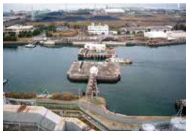
三池港・港口開門
