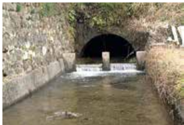
花巡廻水路隧道
