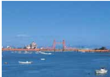
筑後川昇開橋
