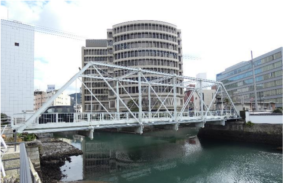
出嶋橋 ●橋の長さ 36.7m ●幅 5.5m ●形式：鉄製トラス橋 [1]
