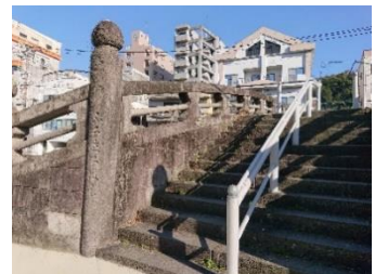
手すり付き階段
