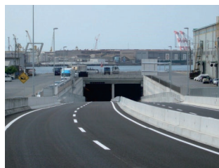
若戸トンネルの戸畑側通行口 (写真:北九州市HPより)
