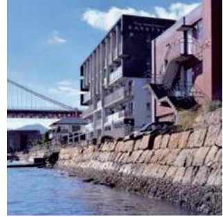
東海岸係船護岸 (提供：北九州市)
