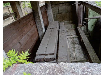
水量を調整する堰板
