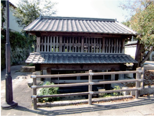
中間唐戸水門
