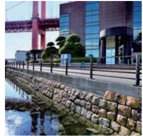
東海岸通護岸 (提供：北九州市)
