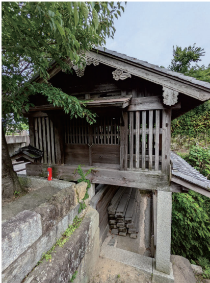
横からみた唐戸水門
