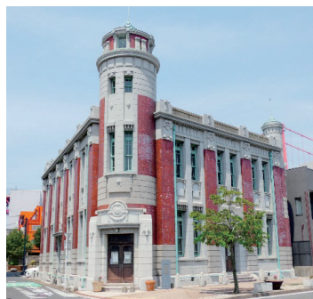
旧古河鉱業若松ビル
