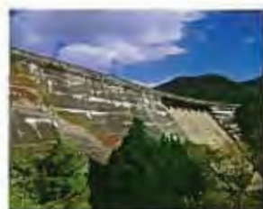
菟田(貯水地)堰堤 長崎県佐世保市
