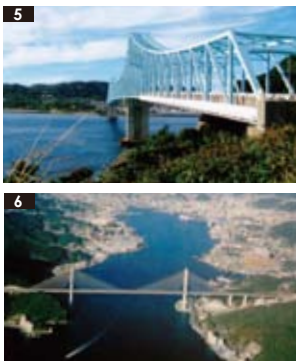
5 生月大橋 (1991年完成) 橋長:960m / 最大支間400m / トラス橋 6 女神大橋 (2005年完成) 橋長:1,289m / 最大支間480m / 長崎湾口
