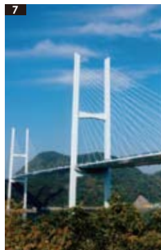
7 肥前鷹島大橋 (2009年完成) 橋長:1,251m / 最大支間400m
