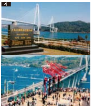
4 大島大橋 (1999年完成) 橋長:1,095m / 最大支間350m / 西海市 大島大橋の竣工式。島民あがての祝賀。 海上では船舶の大パレードが行われた。
