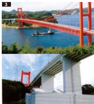
3 平戸大橋 (1977年完成) 橋長:879m / 最大支間465m / 吊り橋 / 平戸市
