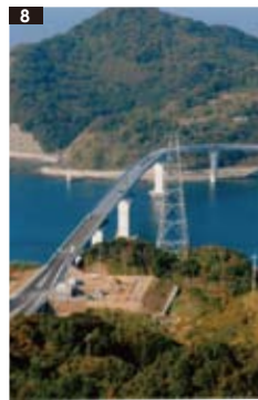
8 伊王島大橋 (2011年完成予定) 橋長:876m / 最大支間240m
