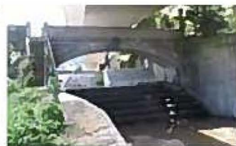
3 本河内下部(水道)堰堤放水路橋 ほんこうちかていすいどうえんていほうすいろきょう
