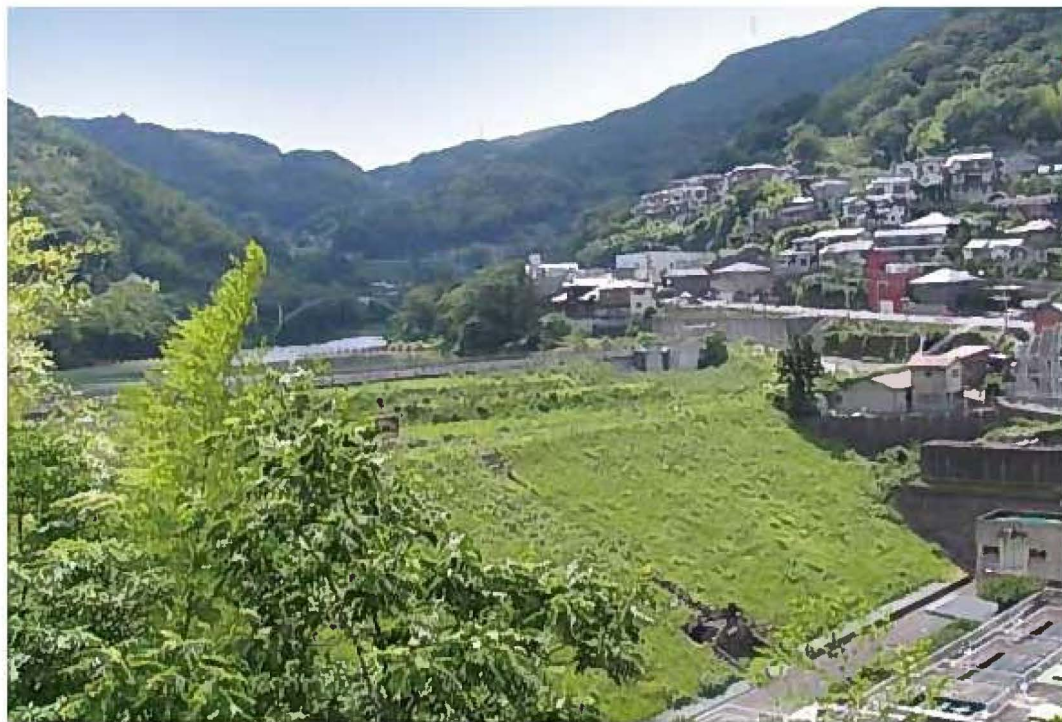
1 本河内上部(水道)堰堤 ほんこうちこうぶすいどうえんてい
