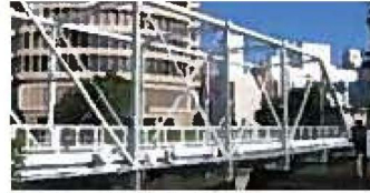
10 出島橋(旧)新川口橋
