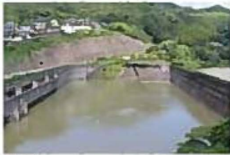
4 西山(水道)堰堤 にしやま(すいどう)えんてい
