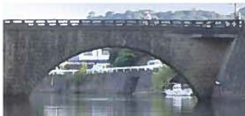
3 堀川橋 ほりかわほし
