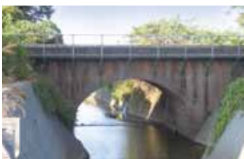
11 倉目川橋・函渠 くらめがわばし・はこぎよ
