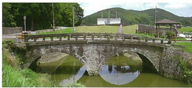
2 江ノ口橋 えのくちはし
