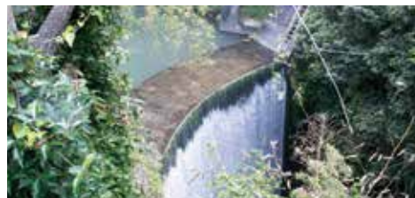
11 宮崎堰堤 みやざきえんてい
