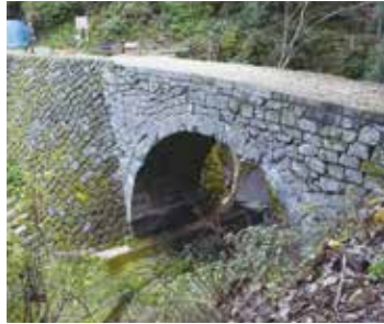
6 雄亀滝橋 おけだけばし
