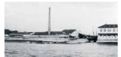
明治18年(1885)頃の若津港渡船場
