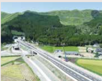
国道57号北側復旧道路の阿蘇市側。奥が二重峠トンネル
