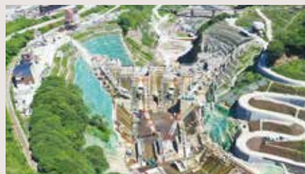
立野ダムの工事状況(令和4年7月末時点)
