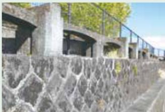
五ヶ瀬川の河口の両岸には、全国的にも珍しい畳堤が980mもの長さで続いています。高さ60cmの鉄筋コンクリート製の堤防は、欄干状の上端に幅7cmの隙間が設けられた構造です。増水時には周辺住民が畳を運び、隙間にはめこんで氾濫を防ぎました。かつては延岡市内の数力所に築造され、総延長は2kmにも及んでいたそうです。
