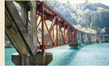
鋼製トラスとV型鉄筋コンクリートの連続【旧第三五ヶ瀬川橋梁】
