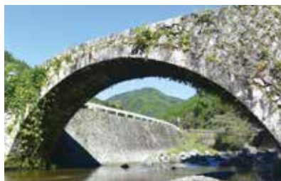
明治2年(1869)、名工橋本勘五郎によって架橋された笠松橋
