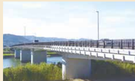
PC橋を張り出して架橋する斬新な工法【夕葉橋】
